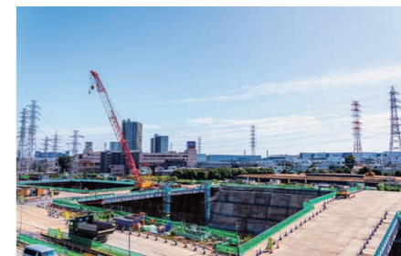
建設工事中のリニア中央新幹線 神奈川駅(仮称)
