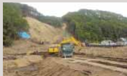
北海道勇払郡厚真町の法面復旧工事①
