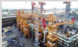
宮城県石巻市の排水ポンプ場建設工事
