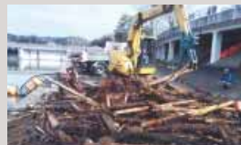
千葉県津市のダム湖流木処理工事
