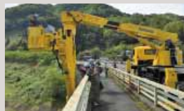
宮城県白石市の大熊橋補修工事
