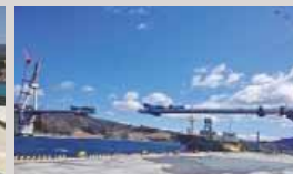
宮城県気仙沼市の気仙沼湾横断橋工事
