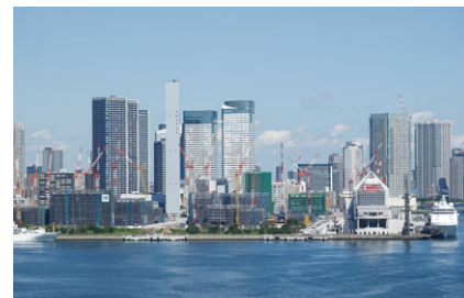
東京五輪関連工場の現場（臨海部）
