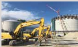
福島県相馬市のLNG基地建設工事
