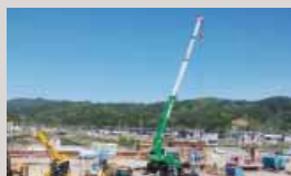
岩手県宮古市の水門復旧工事
