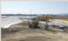
福島県南相馬市の防潮堤工事
