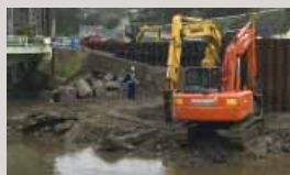
岩手県大船渡市の防潮堤改築工事
