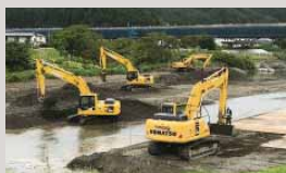
岩手県上閉伊郡大槌町の河川復旧工事
