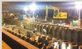
宮城県仙台市の岸壁耐震改良工事
