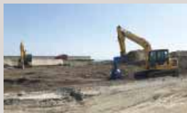
福島県双葉郡双葉町の護岸復旧工事
