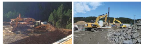
宮城県気仙沼市の三陸道 (左) と復興道路の整備工事
