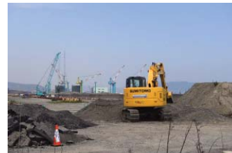
宮城県石巻市の防潮堤工事
