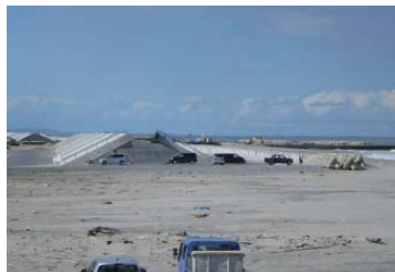
宮城県仙台市の南部海岸防潮堤工事
