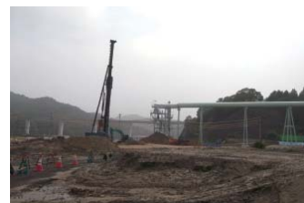
岩手県下閉伊郡の整地（高台移転）工事
