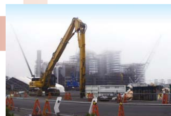
宮城県石巻市の瓦礫解体工事
