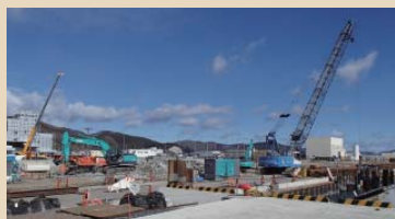
石巻魚市場（宮城県石巻市）の建設工事
