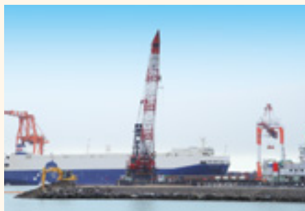
仙台塩釜港(宮城県仙台市)の岸壁築造工事
