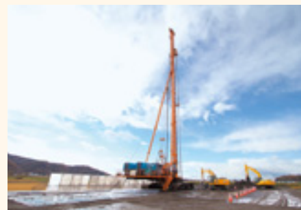
大瓜道路(宮城県石巻市)の改良工事
