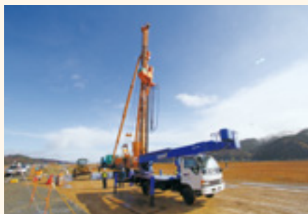
北上川(宮城県石巻市)の護岸工事
