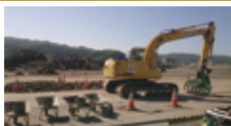
急ピッチで進められる瓦礫処理
