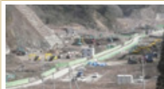
宮城でも着々と進む瓦礫処理
