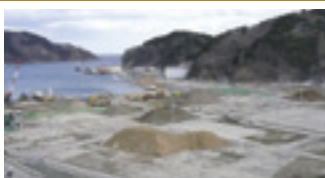
女川漁港の復旧工事現場
