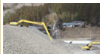
三陸鉄道南リアス線の復旧工事
