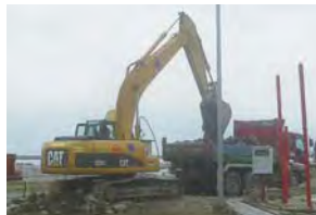
福島県いわき市で小名浜港の復旧工事に使用される当社建機
