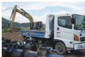
福島県飯館村で除染作業を行う当社の油圧ショベルとトラック
