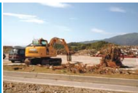
瓦礫撤去作業を行う当社油圧ショベル
