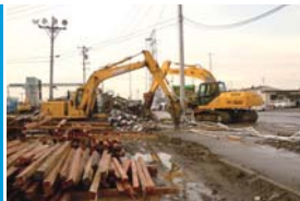
復旧工事が急がれる工場や施設で、瓦礫を撤去・運搬する油圧ショベルとトラック
