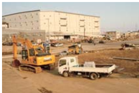
復旧工事が急がれる工場や施設で、瓦礫を撤去・運搬する油圧ショベルとトラック
