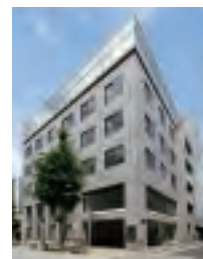
増築した浜松町Kビル
