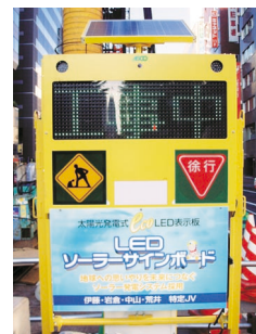
札幌駅前通りの工事現場に設置されている
