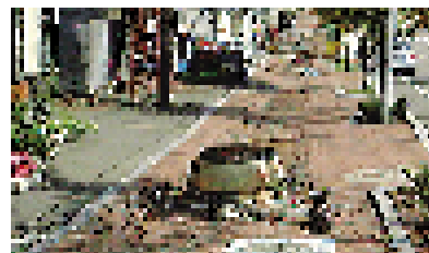
歩道の中央が陥没し、地上に大きくせり出したマンホール
