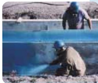
「ポリシールド」とは、ポリウレア樹脂に化学的な改良を加えて強化し、防水・防腐食機能を高めた新素材です。使用したい場所に専用機を用いてスプレーするだけで、ウレタンや
