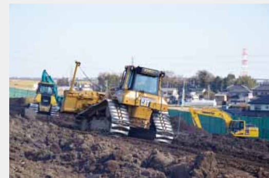
3DMCや3DMGを使った情報化施工 Information-aided construction using 3DMC and 3DMG
