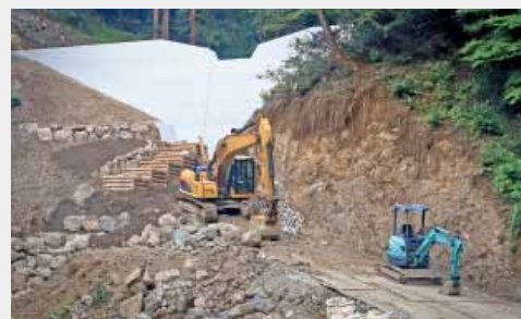
砂防ダムの建設工事 Sabo dam construction works
