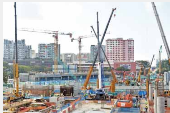
シンガポールで進む再開発の建設工事現場 Construction site for redevelopment to advance in Singapore
