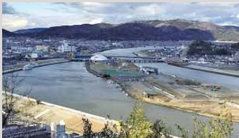
宮城県石巻市の橋梁工事
