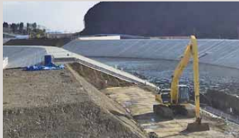
宮城県本吉郡南三陸町の水戸辺河川災害復旧工事
