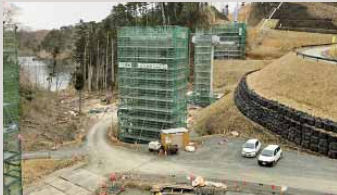
宮城県牡鹿郡女川町の橋梁下部工事
