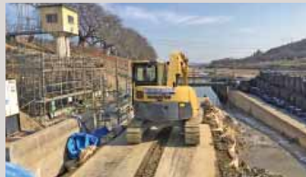
宮城県柴田郡村田町の取水堰工事
