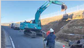
千葉県成田市の空港法面復旧工事
