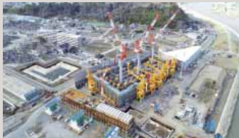
宮城県石巻市の排水ポンプ場建設工事
