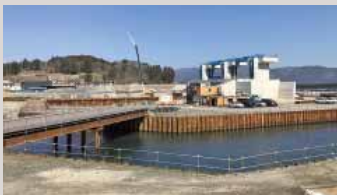
岩手県下閉伊郡山田町の水門工事
