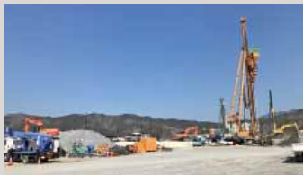
岩手県下閉伊郡山田町の地盤改良工事
