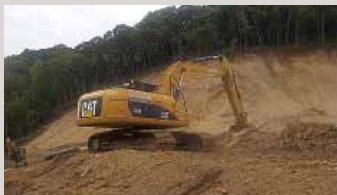
北海道勇払郡厚真町の林道復旧工事
