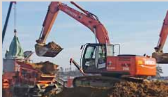
宮城県気仙沼市の道路改良工事
