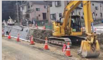
広島県安芸郡坂町の天地川災害復旧工事
