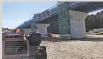
岩手県九戸郡野田村の橋梁上部工事
